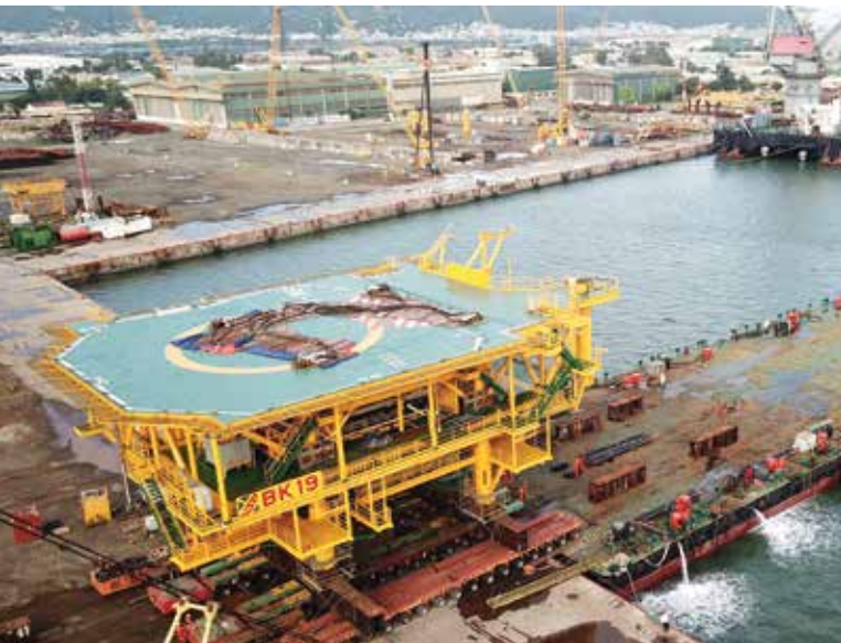
Đẩy nhanh tiến độ đầu tư, đưa mỏ 3 mỏ/công trình dầu khí mới vào khai thác (Sư Tử Trắng phase 2A, BK-18A, BK-19). Ảnh: Hạ thủy khối thượng tầng BK-19
